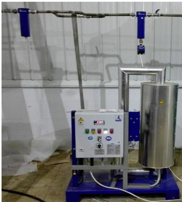
现在客户吹扫核桃仁的工艺现场使用无油催化机（BEKOKAT）之后，压缩空气的含油量完全符合ISO 8573-1的1级标准。
