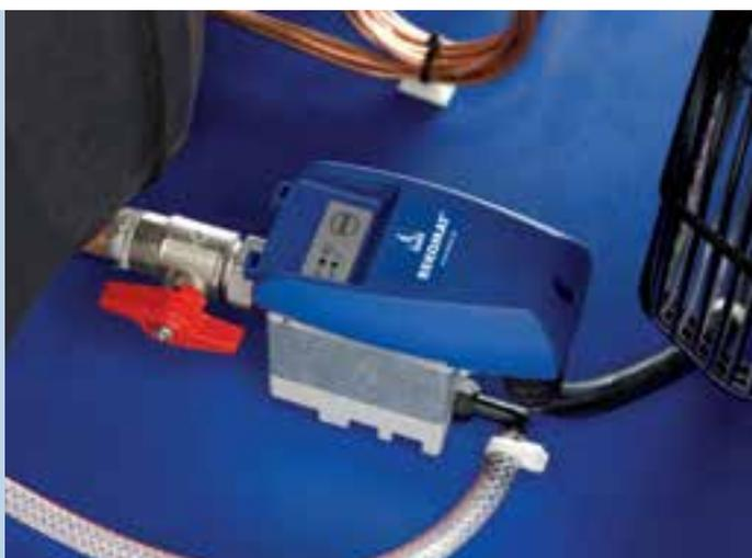
冷凝液排放, 无压缩空气损失
